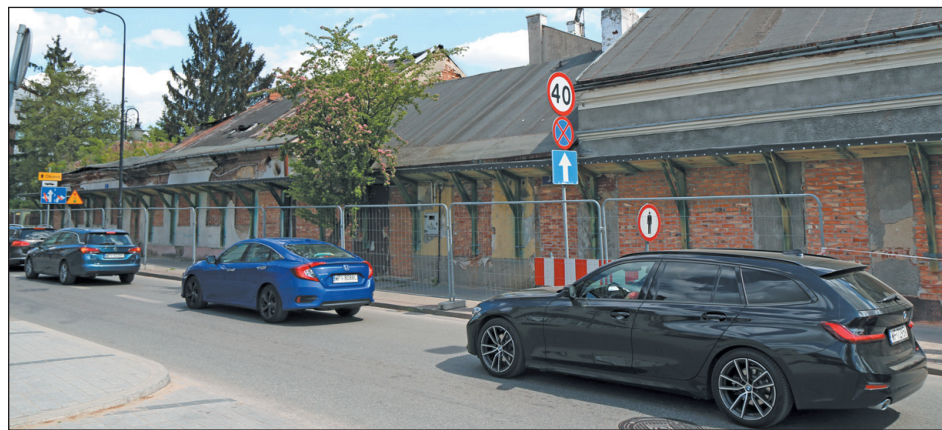
Widok na zabezpieczone budynki przy ul. Warszawskiej
