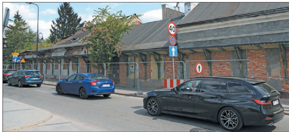
Widok na zabezpieczone budynki przy ul. Warszawskiej
