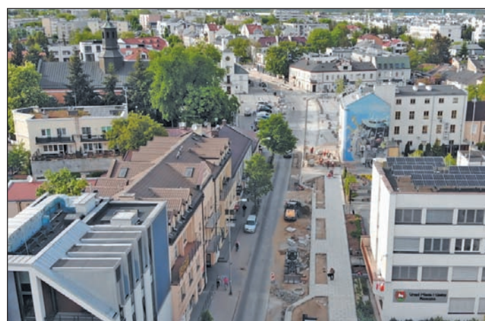
Trwa przebudowa kolejnego fragmentu ul. Puławskiej i Kościuszki
