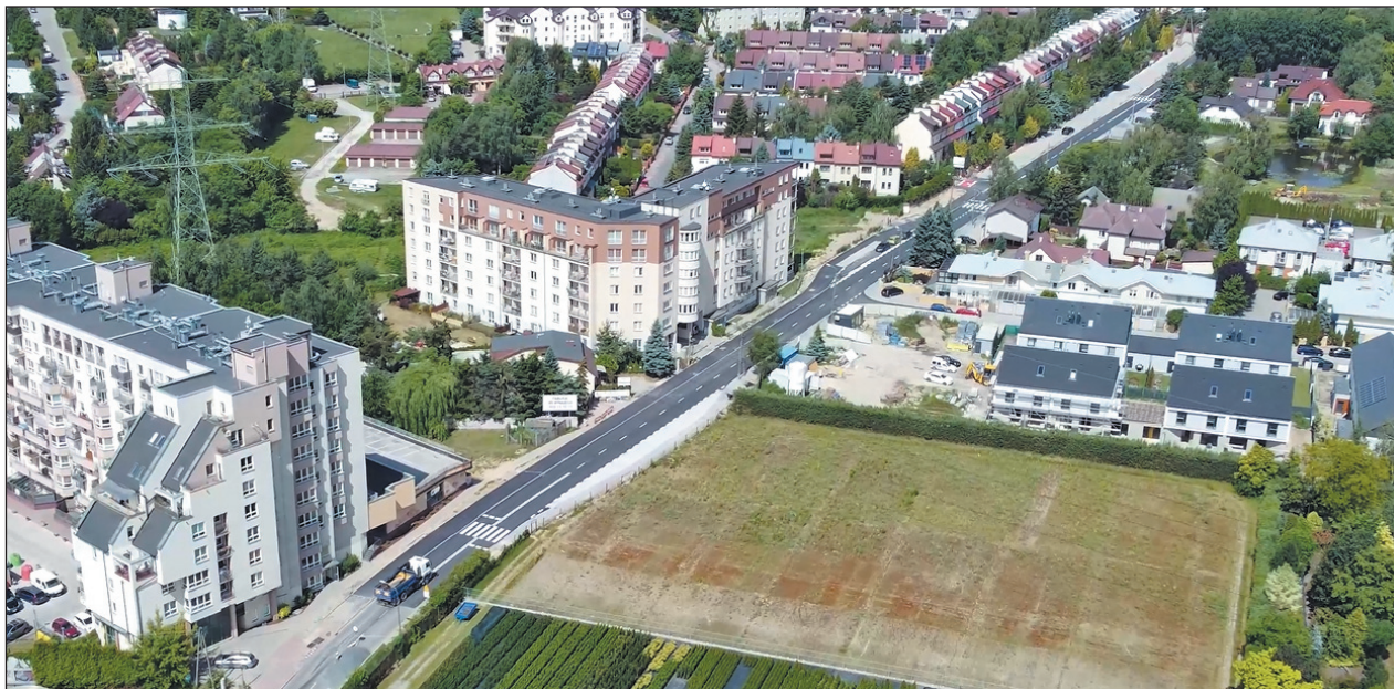
Ulica Geodetów w trakcie modernizacji
