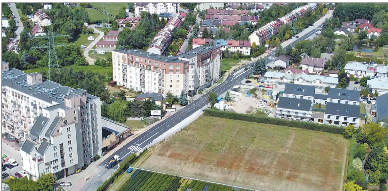
Ulica Geodetów w trakcie modernizacji
