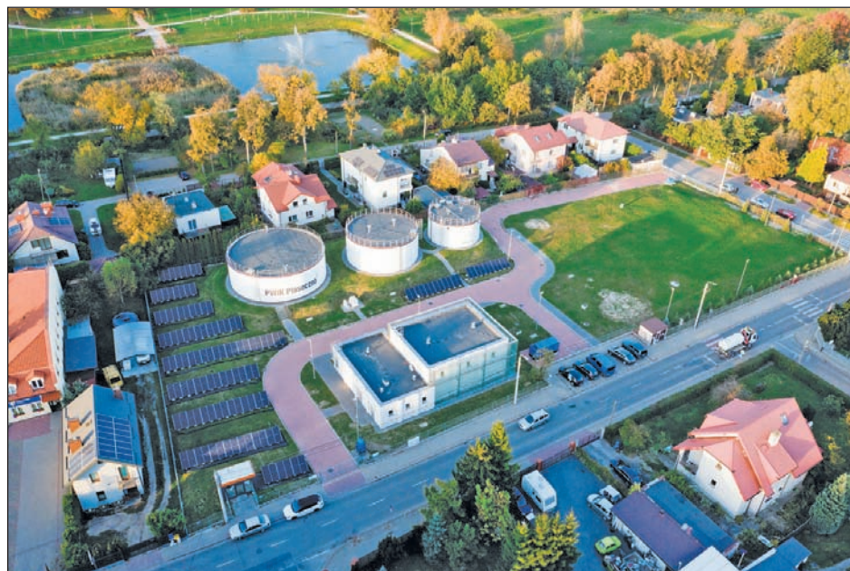
Stacja uzdatniania wody przy ul. Żeromskiego
