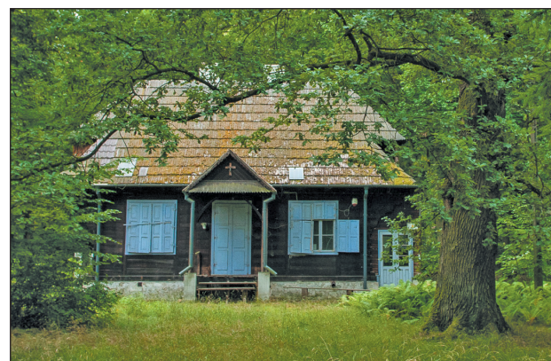
Dom „Zośki” przed modernizacją
