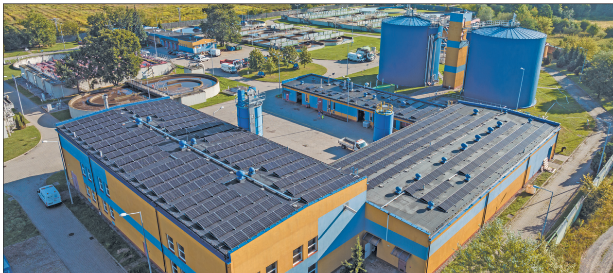
Panele fotowoltaiczne na dachu oczyszczalni ścieków w Piaseczynie
