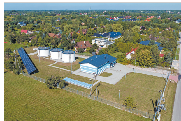
Panele fotowoltaiczne przy SUW w Wólce Kozodawskiej
