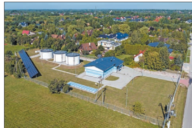
Panele fotowoltaiczne przy SUW w Wólce Kozodawskiej
