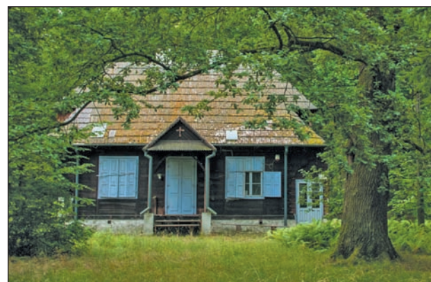
Dom „Zośki” przed modernizacją
