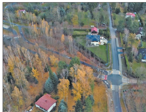
Przebudowane skrzyżowanie ulic Grójeckiej i Grottgera
