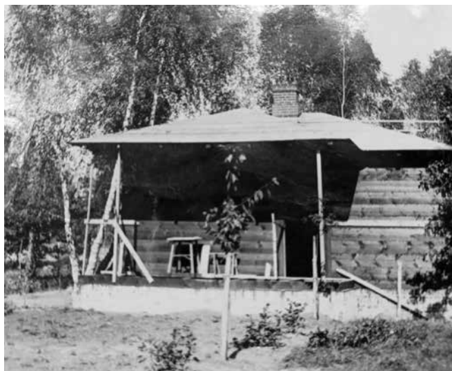
Budowa domu – archiwum prywatne.
