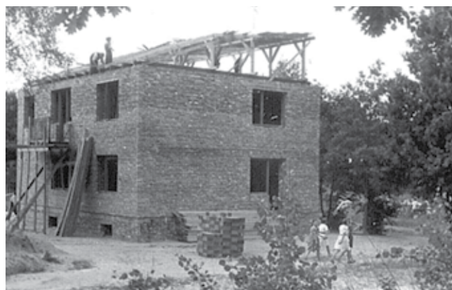
Ośrodek zdrowia przy ulicy Koralewych Dębów w budowie. Zdjęcie z archiwum Grzegorza Fryszczyzna.
