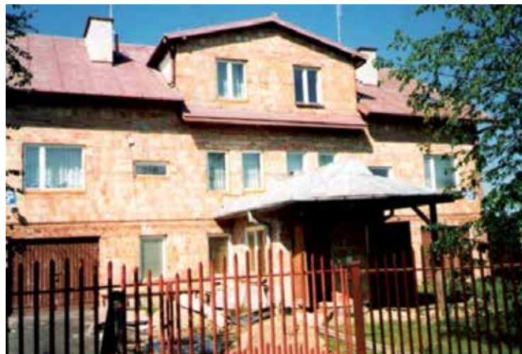
Dom w budowie
