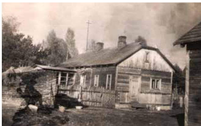
Dom rodziny Juliana Waleckiego przy ulicy Leśnej 1. Zdjęcie z archiwum rodzinnego.
