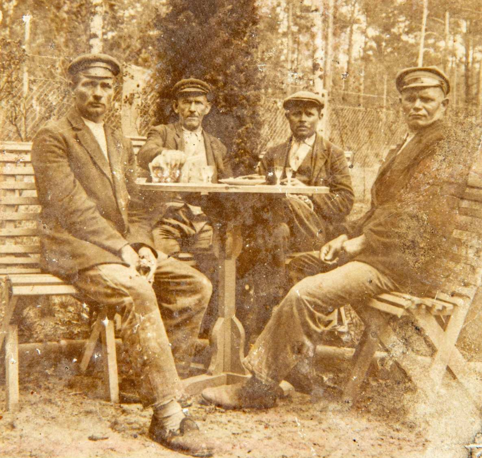
Złotokłos - Odpoczynek na budowie. Źródło: Archiwum P. Edwarda Fruby
