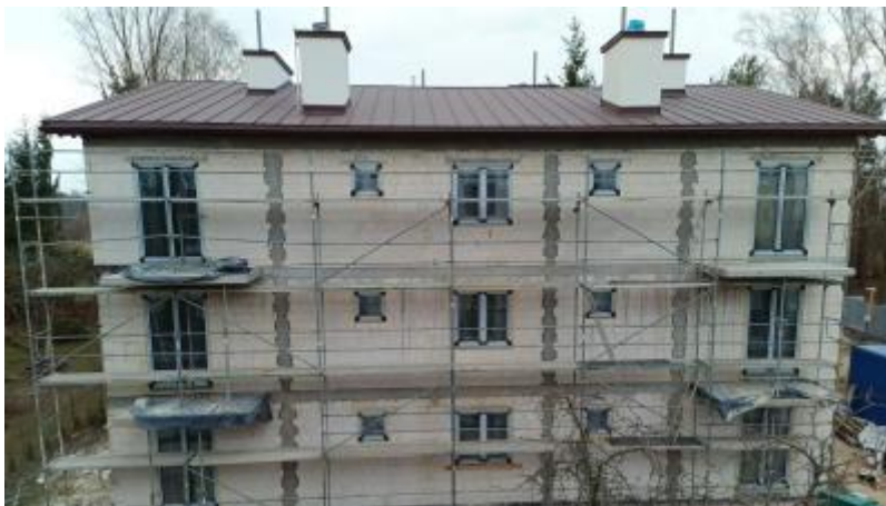
Budynki komunalne Bąkówka, fot.: Marcin Gwardys
